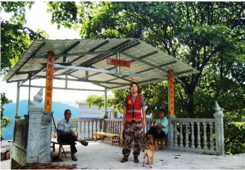
援建大新村的便民凉亭“柳汽亭”建成使用
